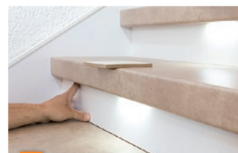
3 Setzstufe – Vertikale Blende
